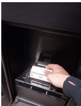
Rys. 15 - Wyjmowanie paleniska
